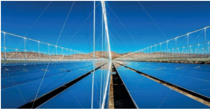
Das Solarthermie-Kraftwerk in Murcia gehört hauptsächlich Schweizer Investoren. La centrale thermique solaire à Murcia appartient principalement à des investisseurs suisses.
